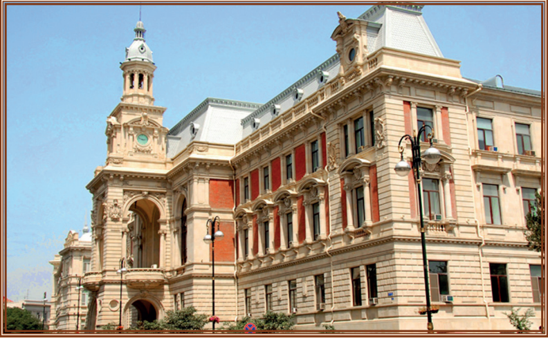
Bakı Şəhər Dumasının binası (1900-1904) Hazırda bura Bakı Şəhər İcra Hakimiyyətinin binasıdır. Memar Y.V.Qoslavski.
