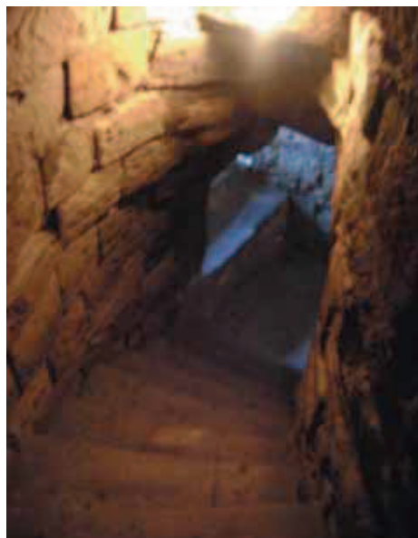
Лестница, выбитая в толще стены
