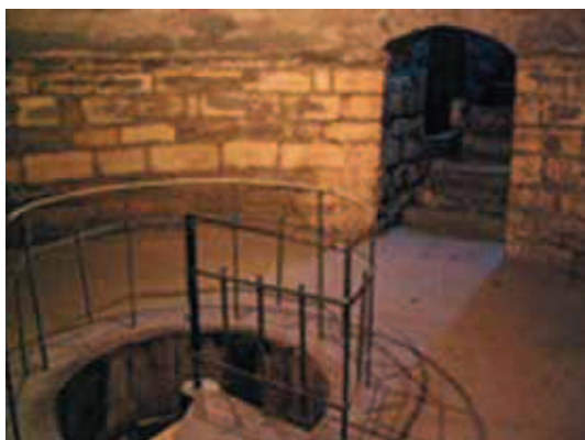
Свод между 1 и 2 этажами Девичьей Башни
