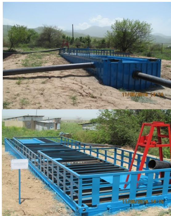
Рисунок 3. Водозаборное сооружение для самонапорной системы капельного орошения
