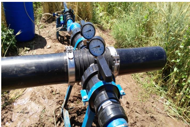
Рисунок 5. Узел фильтрации и фертигации на ОПУ КХ «Нуржан», площадь 4,5 га
