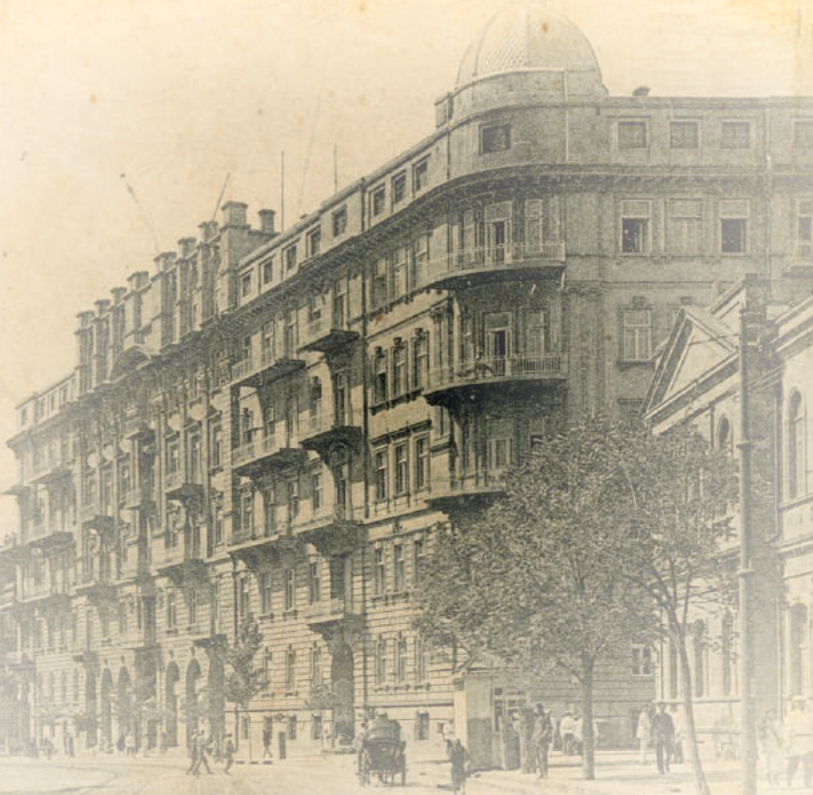
Ukrayna nümayəndəliyinin binası və Mirzəbəyov qardaşlarının malikanəsində yerləşən Ukrayna Milli Şurası. İstiqlaliyyət küçəsi, 8
